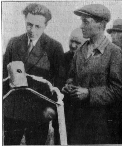
Abb. 44 Der erste Repulsor. Links W. Ley. Der Sauerstofftank ist weiß ver- eist. Man kann deutlich erkennen, wo der Motor durchbrannte.
