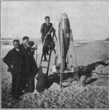
Abb. 32 Bei der Füllung der Höhenrakete HW 2 mit flüssigem Sauerstoff auf der Frischen Nehrung. Links Ing. Winkler. Der Unterstand, von dem aus die Rakete eingeschaltet wurde, befindet sich etwas weiter rechts.
